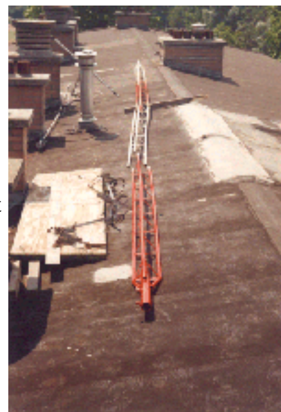
Zomer 1996. Voorbereidingen voor het plaatsen van een nieuwe mast.
